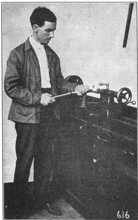
Fig. 27. Using Skew Chisel.
